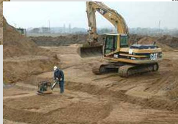
Rückbau einer Bohrschlammgrube
