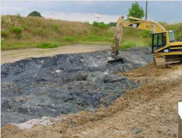
Rückbau einer Bohrschlammgrube
