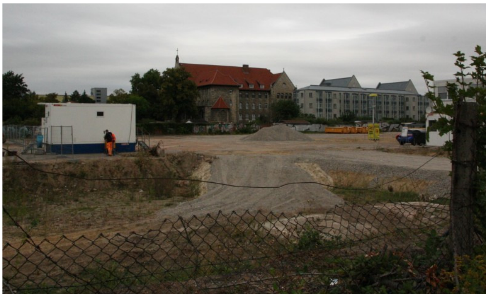
Vor der geplanten Neubebauung werden auf dem Gelände der ehemaligen Lackfabrik am Europaring Schadstoffe aus dem Boden entfernt. Foto: Stefan Harter
