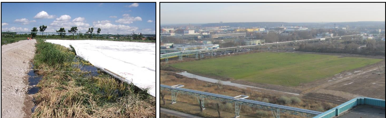
Abbildung 4: Sanierung/Sicherung der Klärteiche Süd durch Oberflächenabdeckung
