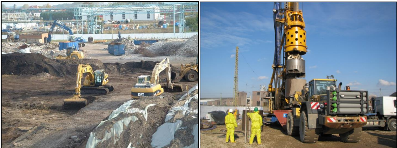
Abbildung 3: Maßnahmen der Boden- und Quellsanierung durch Bodenaustausch
