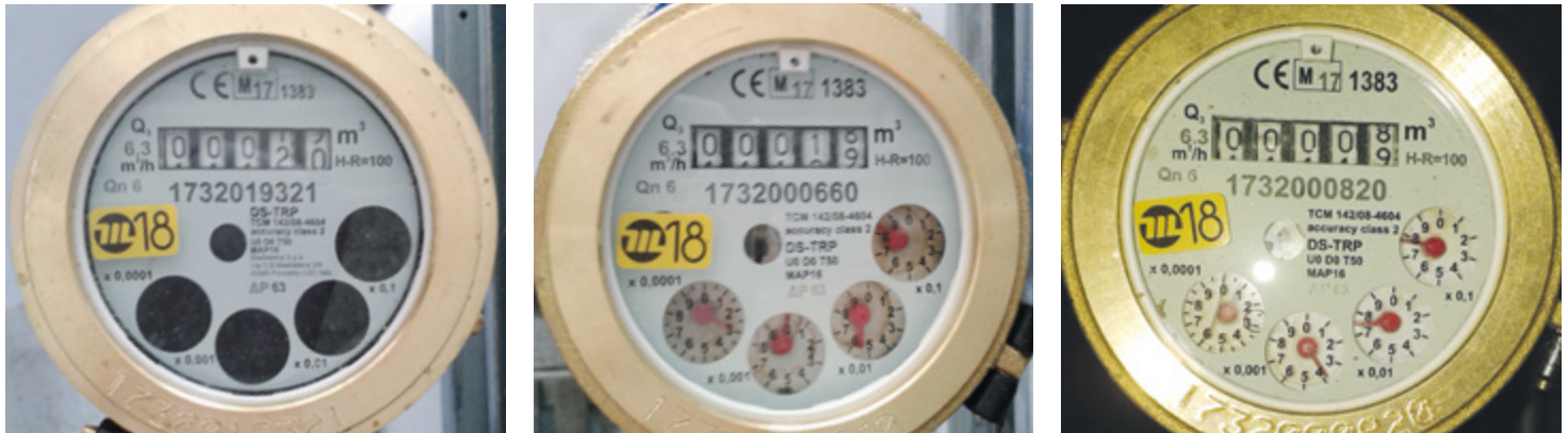
Sanierung wird sichtbar: Die Veränderung der Wasserqualitäten vom Zulauf in die Anlage (Rohwasser) bis zum Ablauf wird in den Anzeigeskalen der Durchflussmessgeräte sichtbar und verändert sich von schwarz auf vollkommen durchsichtig.
