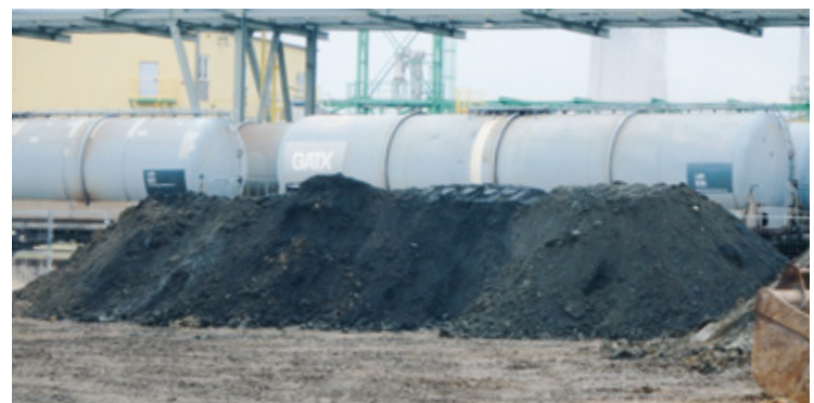
Separierter kontaminierter Bodenaushub
