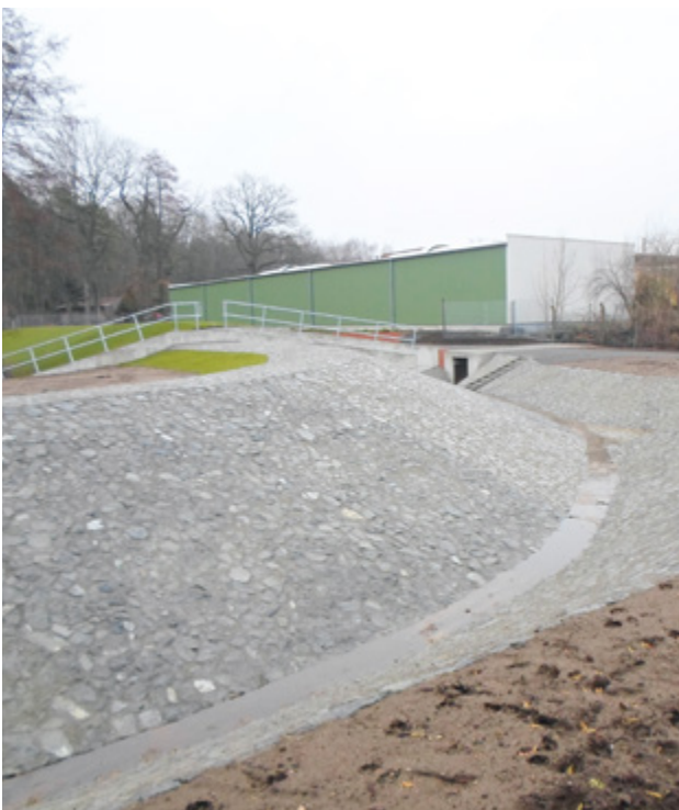
Rückhalteraum Rischebach in Reinsdorf (Siehe Karte 2014-0119)
