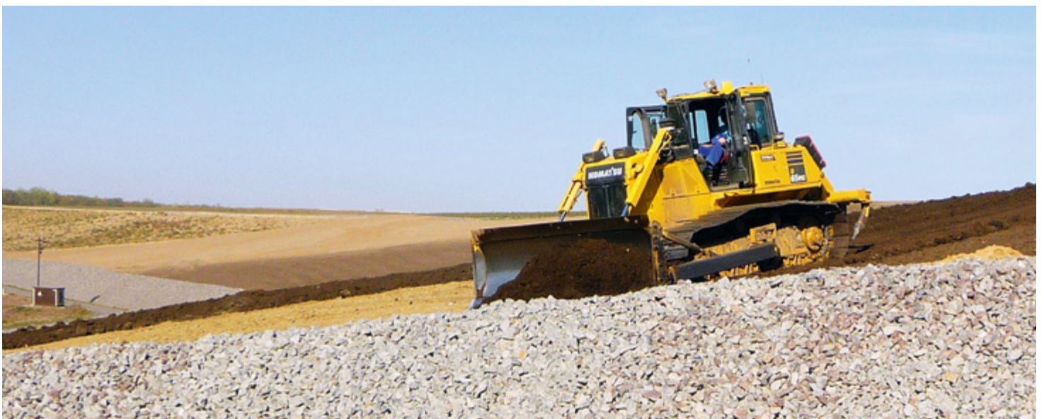
Erdarbeiten 2018 zur Herstellung der Oberflächenabdeckung an der Deponie Freiheit III
