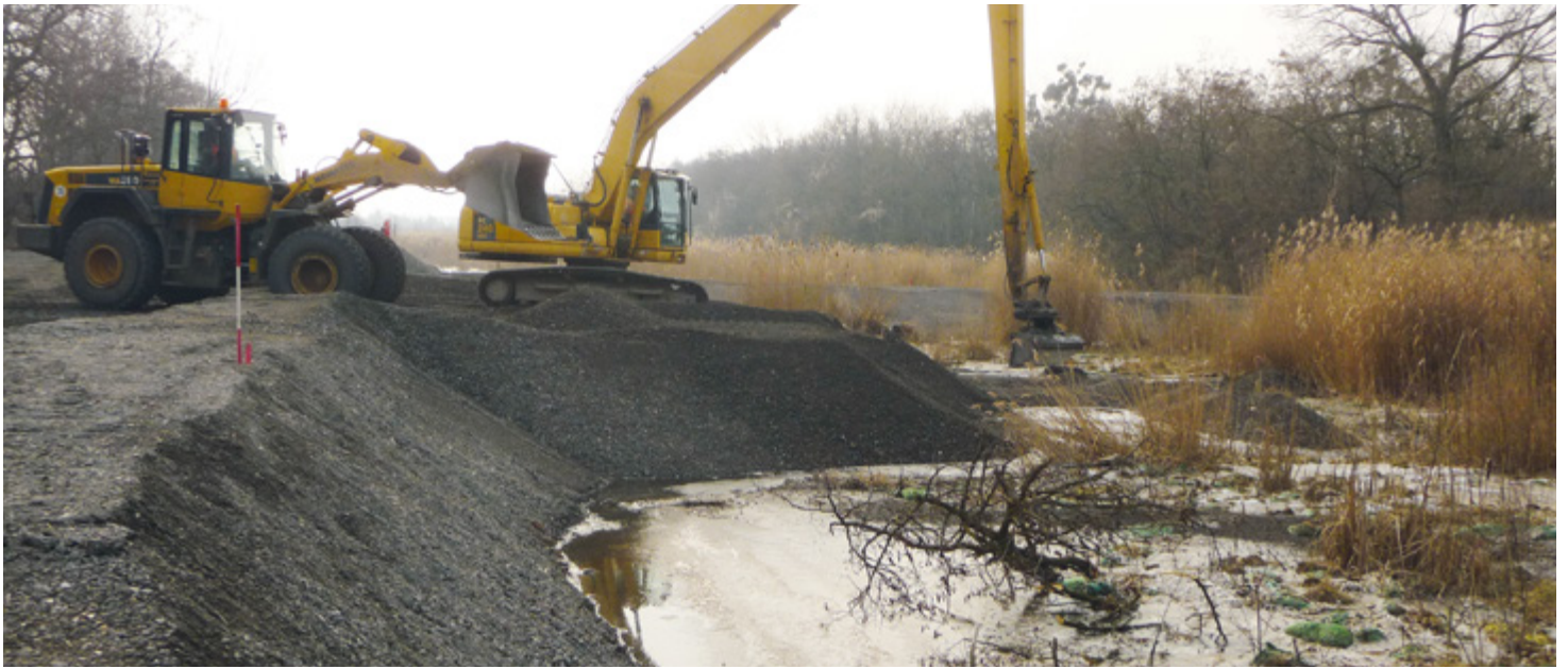
Deponie Grube Johannes: Bauarbeiten zur Verfüllung des Nordschlauches (2017)
