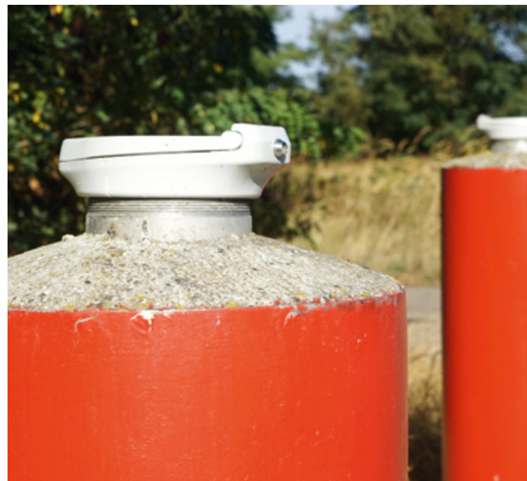
Messstellen zur Überwachung des Grundwassers
