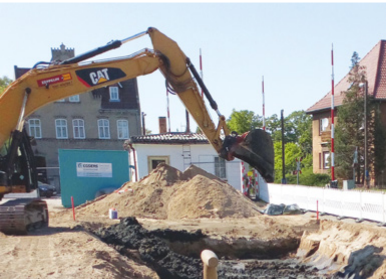
Aushub von belastetem Boden
