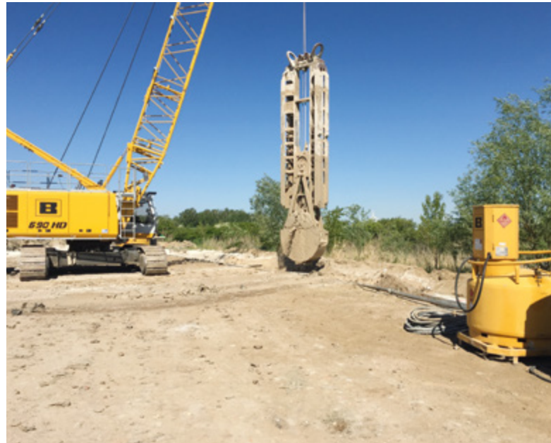
Errichtung einer Dichtwand parallel zu den Kleyteichen
