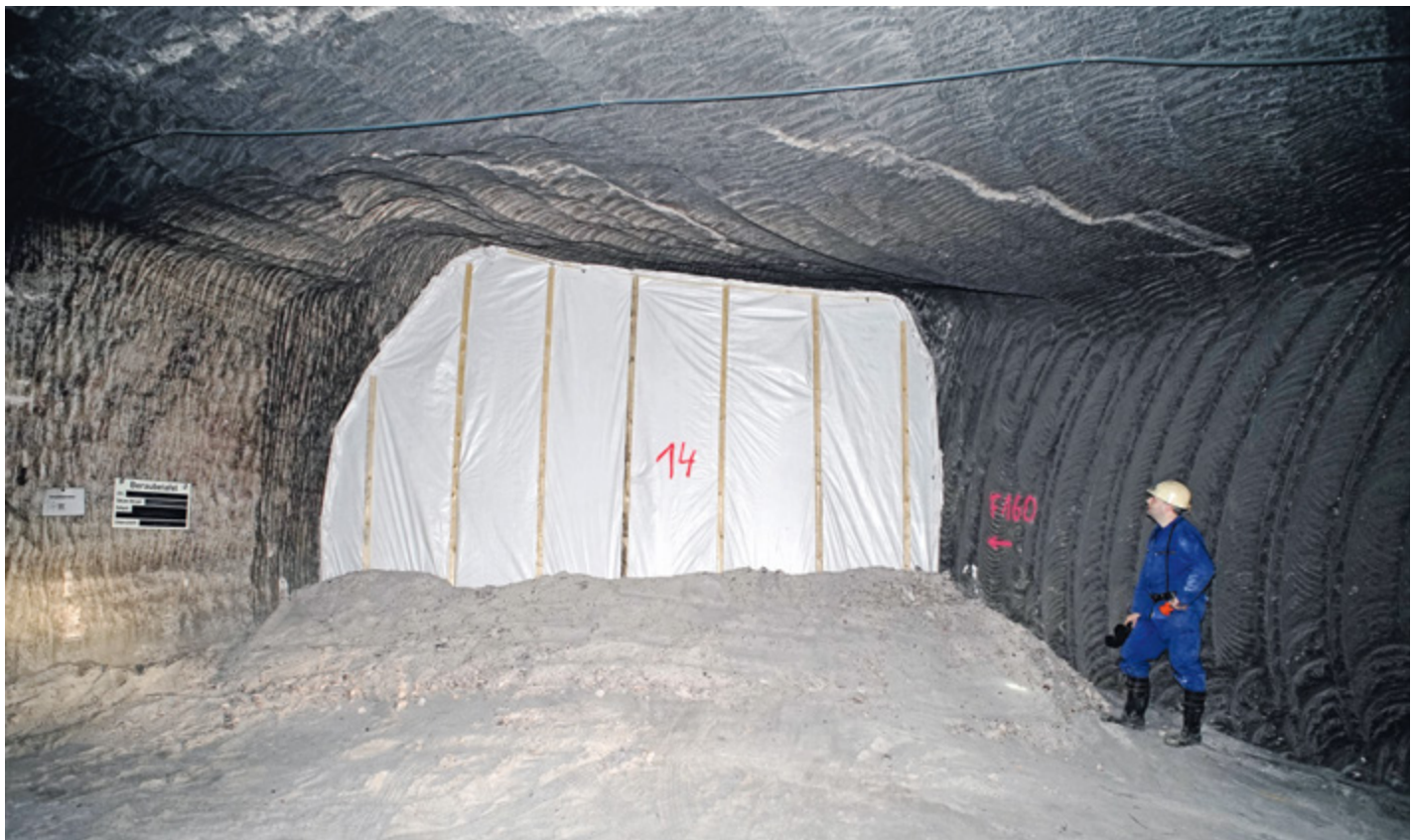
Mit Feststoffen teilverfüllte Abbaukammer
