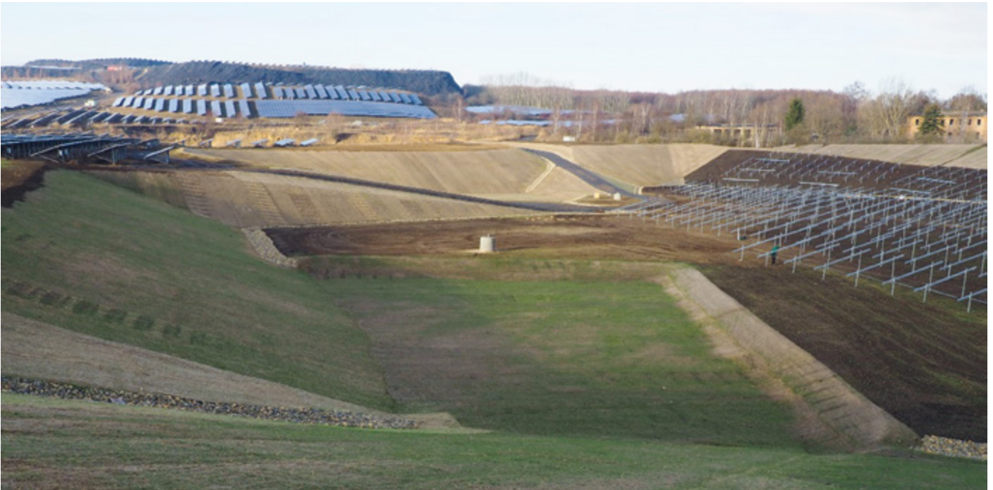
Blick auf die abgedeckte Weihnachtshalde mit dem Verdunstungsbecken im Vordergrund. Im Hintergrund erkennbar, werden die Solaranlagen bereits wieder aufgebaut.
