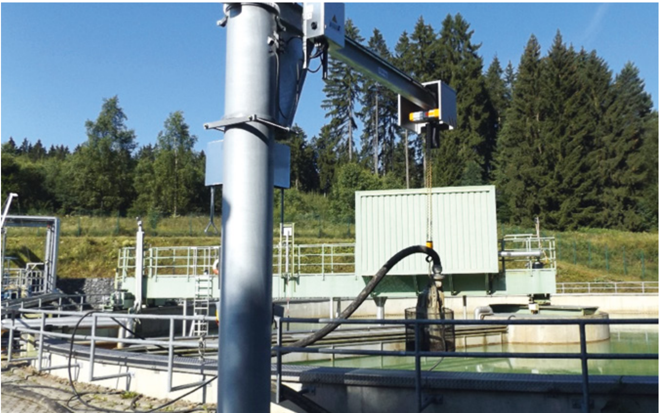
Rührbecken der Grubenwasserreinigungsanlage im Uhlenbachtal
