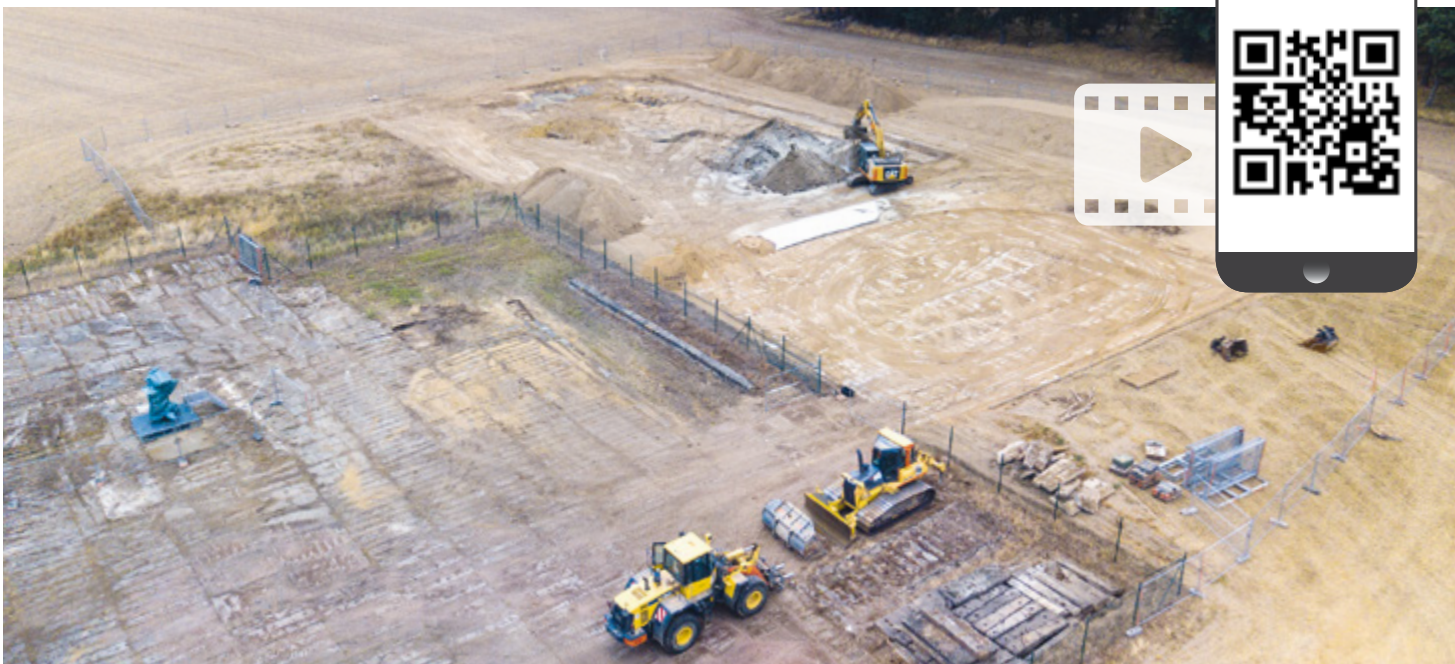
Sanierung von Bohrschlammgruben am Beispiel des Betriebspunktes Peckensen 151
