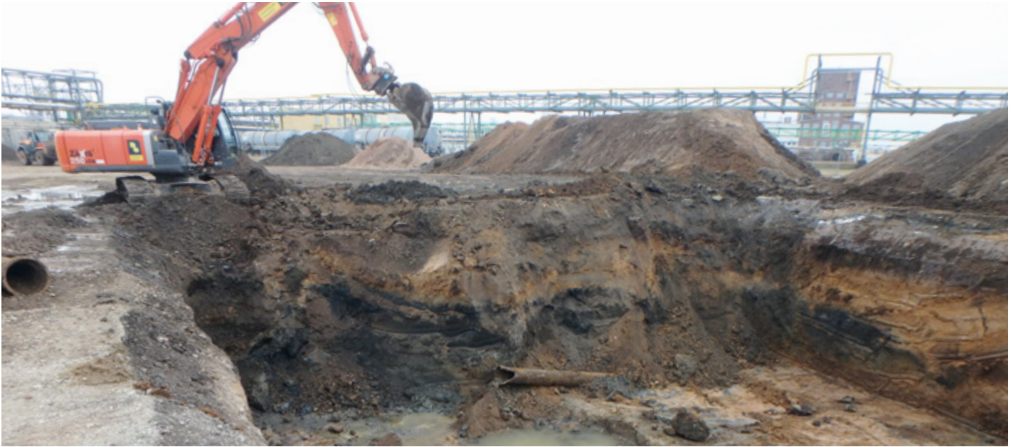
Aushub kontaminierter Bereiche (schwarze Schichten)
