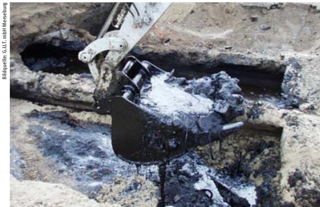
Entnahme von z.T. flüssigem Teer bei der Leerung der aufgefundenen Teergrube
