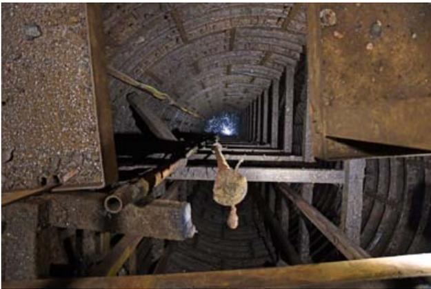
Schacht Saale: Blick von der Arbeitsbühne bei -42 m nach unten in den Aufwältigungsbereich bis zum abgesenkten Süßwasserspiegel
