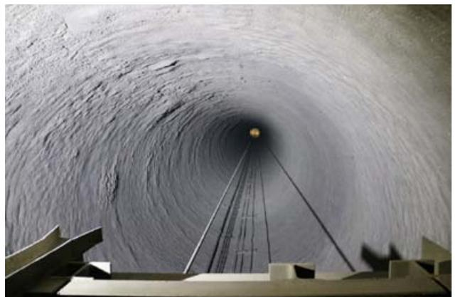
Grubenfeld Angersdorf, Schacht Halle: Blick in den sanierten Schacht vom Förderkorb aus nach unten zur beleuchteten Leine-Steinsalz-Sohle (-644 m Sohle)
