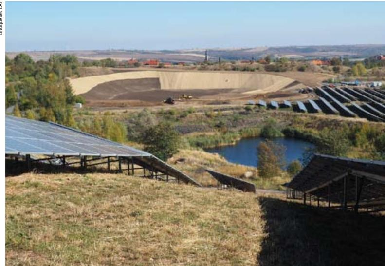
Blick auf die profilierte und mit einer Wasserhaushaltsschicht abgedeckte ehemalige Weihnachtshalde (morphologische Senke). Die hellen Bereiche sind Strohmatte, die dem Erosionsschutz dienen, bis die Vegetationsdecke etabliert ist.
