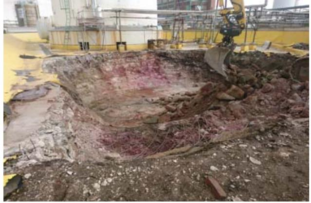
Bauvorhaben Remondis: Phenolkontaminationen beim Rückbau der Tankfundamente
