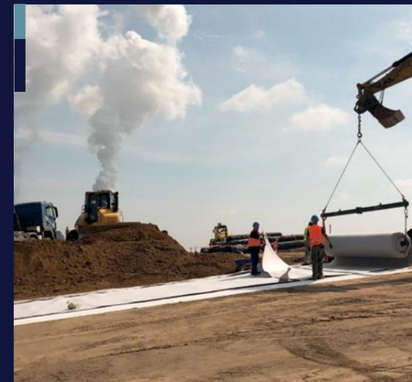
Hochhalde Schkopau, Altdeponie 8, Bauarbeiten zur Oberflächenabdichtung | © LAF
