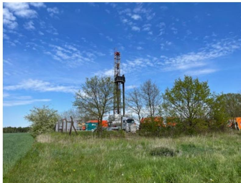
Verfüllung der Bohrung Altensalzwedel 2 mit einer Workover Anlage | © LAF
