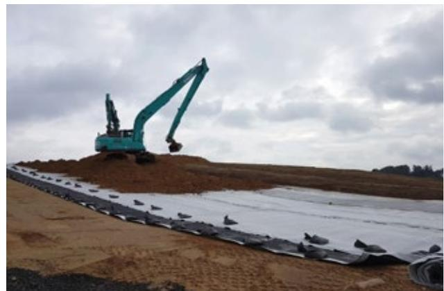
**Einbau des Unterbodens auf geosynthetischer Tondichtungsbahn, Kunststoffdichtungsbahn und geosynthetischem Dränelement im westlichen Teilfeld II Nord des Tontagebaus Vehlitz** | © DEPOSERV GmbH
