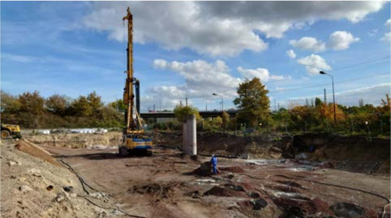
Die Aufnahme zeigt die Sanierung des Standortes der Fa. StaHaB mittels eines sogenannten Großlochbohrverfahrens | © LAF
