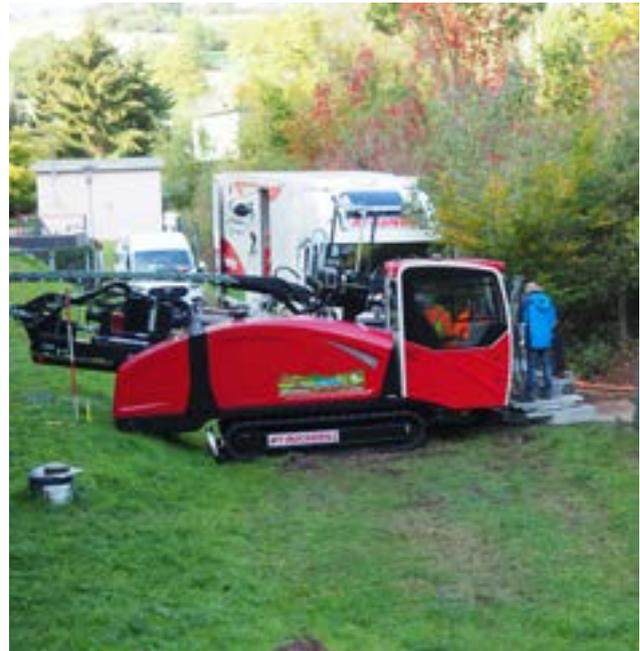
Horizontalbohrverfahren zur Errichtung der Druckleitung im Bereich der Pumpstation Stadtborn. | © LAF
