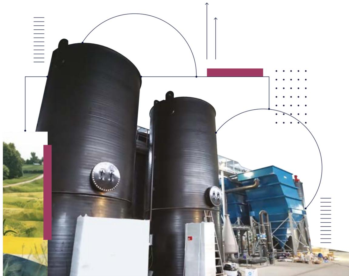
Komponenten der neuen Neutra-Anlage, dem Kernstück des Sickerwasserbehandlungssystems in Helbra. | © LAF
