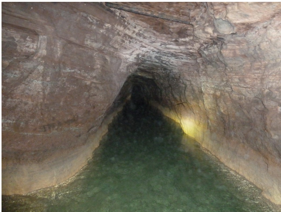
Foto 2: Schlüsselstollen am Lichtloch 20Z; Probenahmepunkt der Wasserprobe 1 (21.07.2011)
