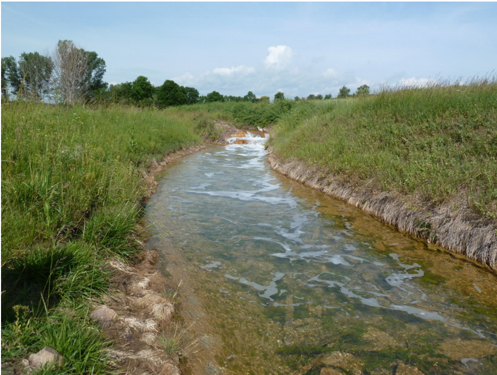
Foto 5: Schlüsselstollen, oberirdischer Abfluss vor Zusammenschluss mit Schlenze; Probenahmepunkt der Wasserprobe 11 und Sedimentprobe C: (20.07.2011)
